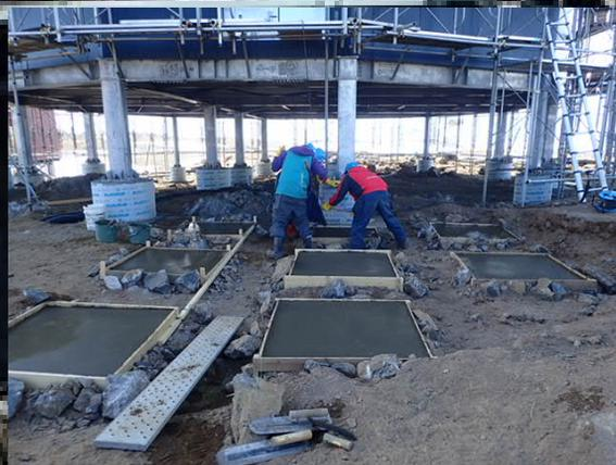
こちらは基本観測棟の階段部分の土台となるコンクリート打設が完了した写真です。作業するスタッフと比較すると、基本観測棟の高床の高さがわかります。
