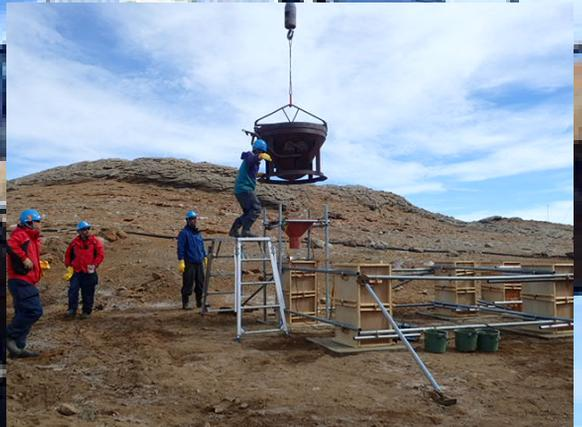
いよいよコンクリートの打設！鉄筋を組んだ束基礎の型枠に生コンを打設してゆきます！
