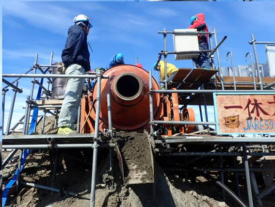
プラントで生成した生コンを工事現場に運ぶため、クレーンで吊り下げるに移します。南極にミキサー車はありません。固まってしまうよう、時間との戦いでもあります！
