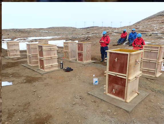
コンクリートを流し込む型枠が完成しました！あとはコンクリートの打設を待つばかりです。ミサワホームのスタッフが作業を監督しますが、他の方々は慣れない作業で(しかも南極という慣れない環境で)たいへんだと思います！
