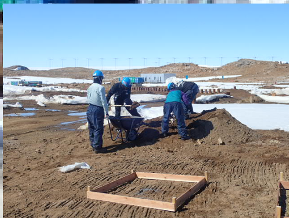
地面の掘削、整地作業後、東基礎が乗る土台の枠を組みます。写真には4人の作業スタッフが写っていますが、研究者の方など建築に関しては素人の方がほとんどで、プロの職人はいません。
