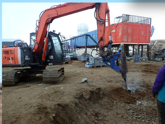
1枚目と2枚目は基礎工事のスタート、地面の根切り作業の写真です。残念ながら基本観測棟の工事ではないようです。日本国内と同様、基礎工事のスタートは地面の掘削作業から始まります。
