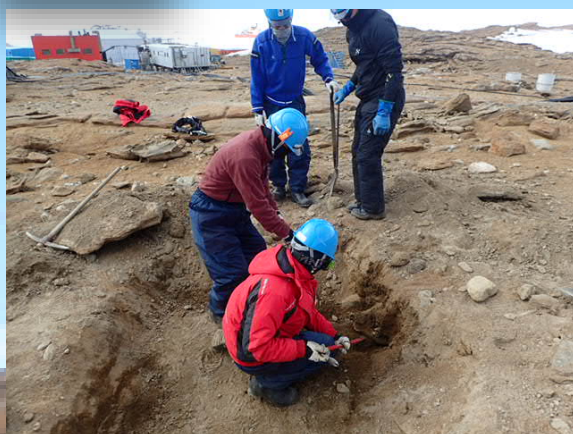
今週から数週間にわたって、南極での基本観測棟をメインとした建築工事の様子をご紹介します！先週末までの雄大な南極の自然の絶景から、建築現場の作業風景へとガラリと内容が変わります！
