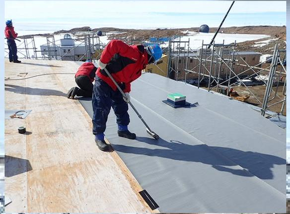
まずは屋根の防水工事から。屋根パネルの上にグレーの防水シートを敷き詰めてゆきます。日本のように雨は降らないかもしれませんが、重要な防水工程です!
