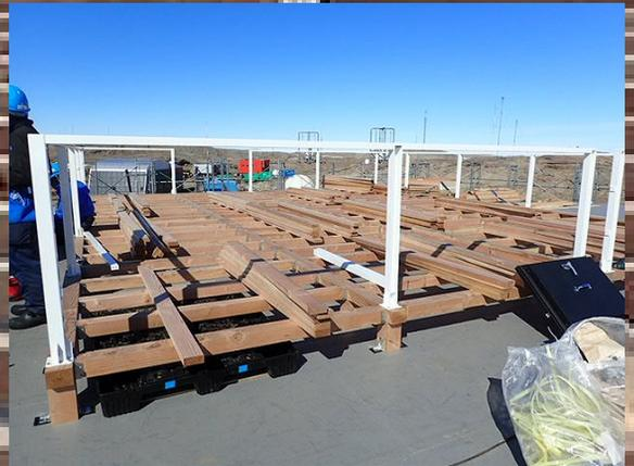
格子状にデッキの土台を組み上げてゆきます! 土台と床は木材、手すりは鉄骨のデッキです!
