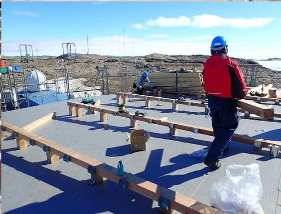
基本観測棟は、屋上で気象観測棟を行うために屋上にデッキが設置されます! 防水工事完了後、続けて屋上デッキの工事に着手!
